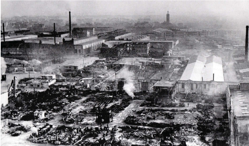
Die Fabrik Heinrich Lanz in Mannheim in Trümmern
